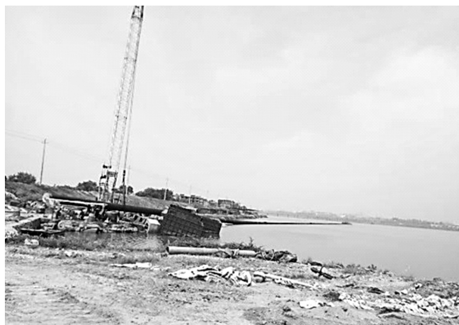
照片1 管道制作
