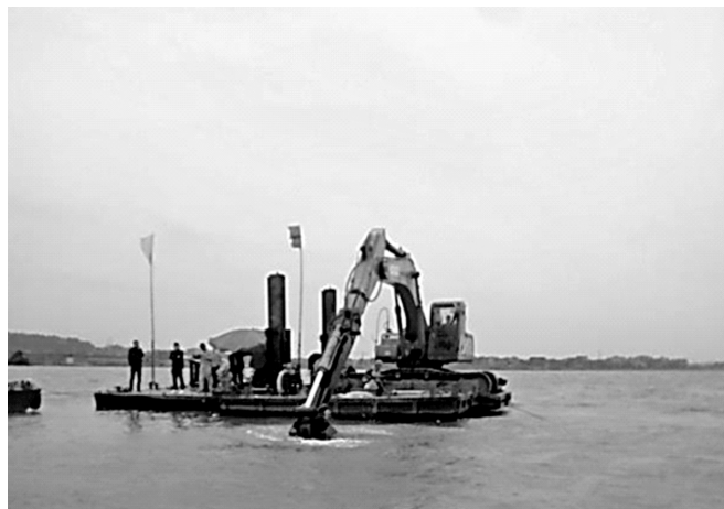
照片2 管槽开挖
