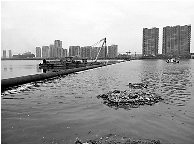
照片3 管道下沉入槽
