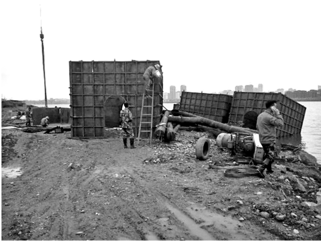
照片4 水下镇墩模板制作
