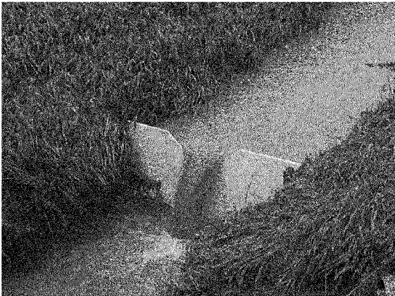
图 2 三角堰现场安装示意图
