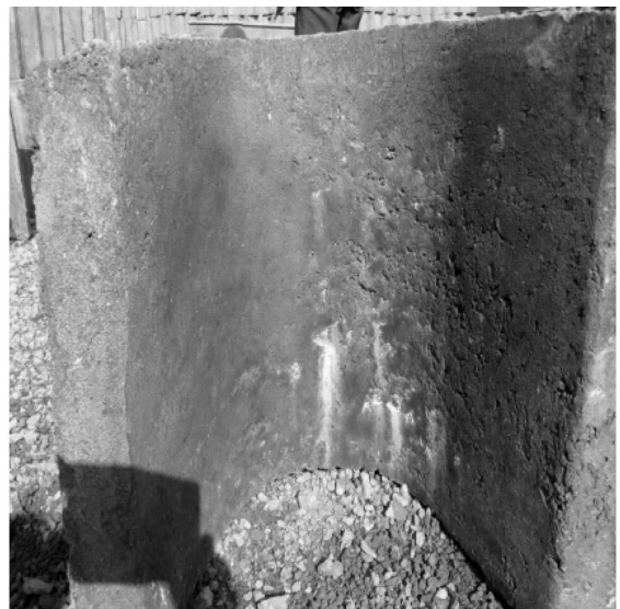
照片 2 C35 的 U 型槽混凝土构件
