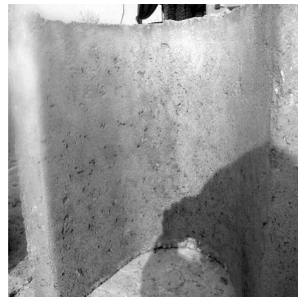
照片 5 S60 的 U 型槽构件
