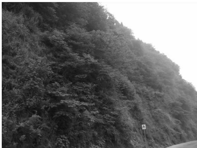
照片1 隔河岩水电站边坡生态防护防护整体效果
